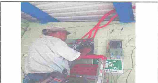
Foto 6: Sustitucion de ducto eléctrico + accesorios EORM Aldea Chuaquenum
