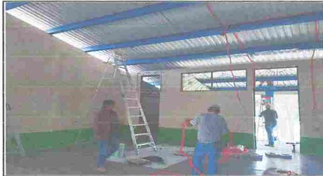
Foto 3: sustitucion del cableado de la energia electrica de 4 aulas EORM Aldea Chuaquenum.
