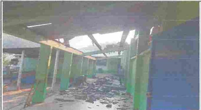
Foto 4: desmontaje del techo de duralita para reemplazarlo por láminas de metal EORM. Aldea Chuaquenum.
