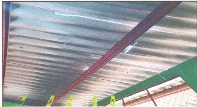
Foto 2: Sustitución de Láminas, Mantenimiento a estructura soporte de metal
