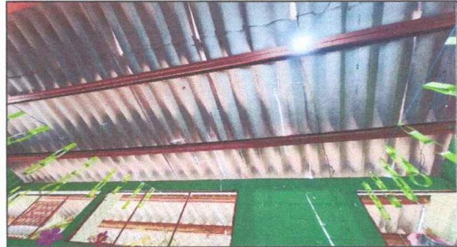
Foto 4: Sustitución de Láminas, Mantenimiento a estructura soporte de metal
