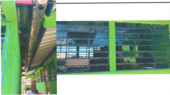
Foto 3: sustitución de desagüe pluvial y sustitucion de vidrios
