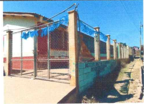
foto 4: Sustitución del portón, la malla perimetral y pintura de la escuela
