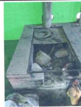
Foto 6: sustitucion de la plancha de la cocina de la escuela
