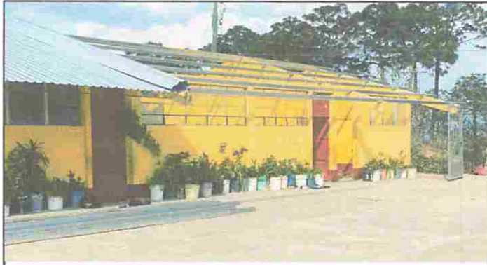
Modulo 1: Sustitucion de lamina, sustitucion de capote, sustitucion de estructura.
