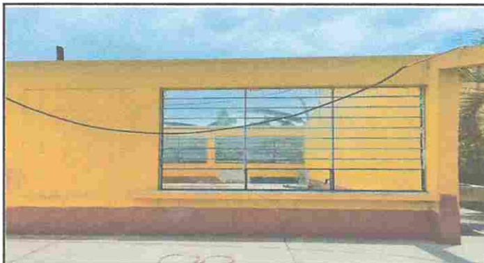
Modulo 2: Sustitucion de lamina, sustitucion de capote, sustitucion de estructura.
