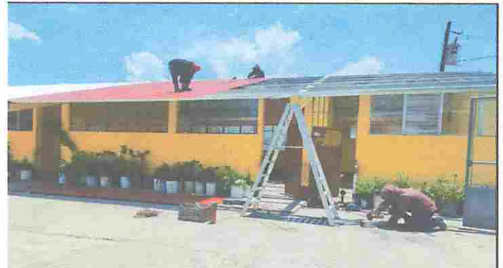
Modulo 1: Sustitucion de lamina, sustitucion de capote, sustitucion de estructura.
