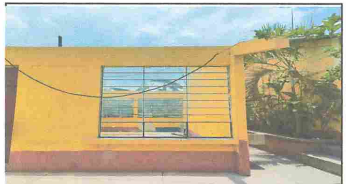
Modulo 2: Sustitucion de lamina, sustitucion de capote, sustitucion de estructura.
