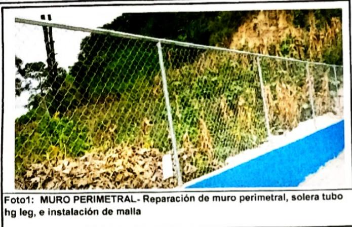
Foto 1: MURO PERIMETRAL- Reparación de muro perimetral, solera tubo hg leg, e instalación de malla
