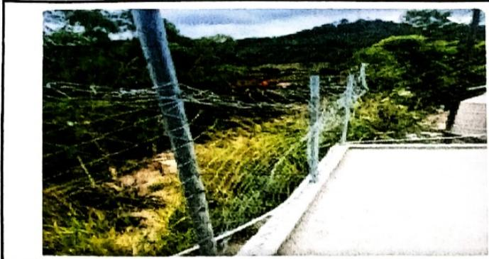
Foto 1: MURO PERIMETRAL- Reparación de muro perimetral, solera tubo hg leg, e instalación de malla
