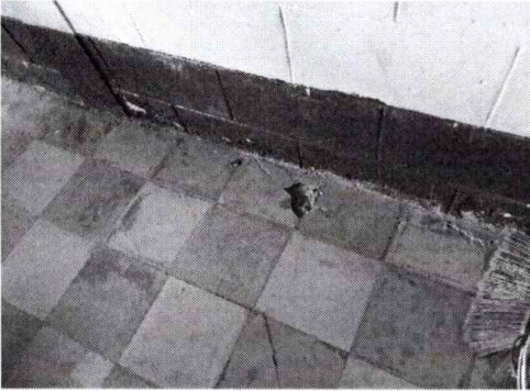
Foto1: MODULO I: SUSTITUCION DE TORTA DE CONCRETO POR PISO CERAMICO
