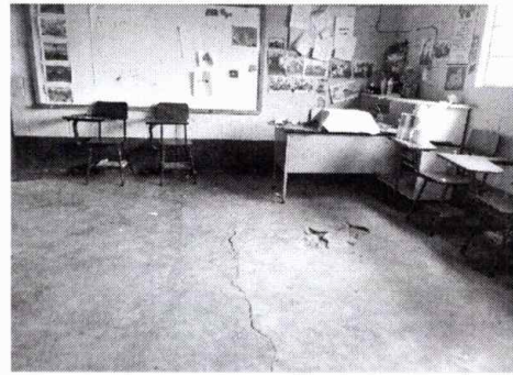
Foto 4: MODULO II: SUSTITUCION DE TORTA DE CONCRETO POR PISO CERAMICO
