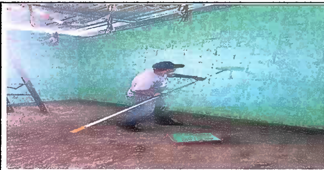
Foto 5: PINTURA DEL EDIFICIO ESCOLAR
