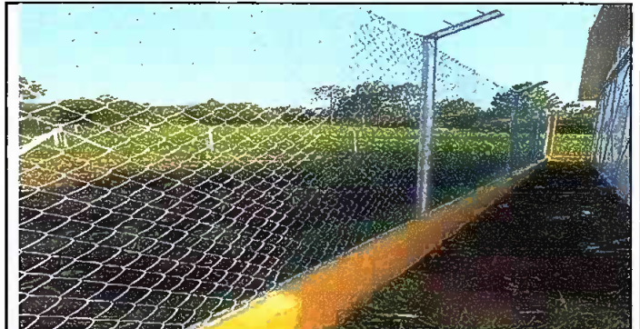
Foto 2: REPARACION DE TUBO HG Y MALLA GALBANIZADA
