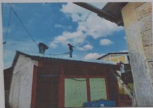
Foto 3: SUSTITUCION DE LAMINA, POR LAMINA TROQUELADA, CALIBRE 26. SUSTITUCION DE CAPOTE DE LAMINA, PARA LAMINA TROQUELADA.
