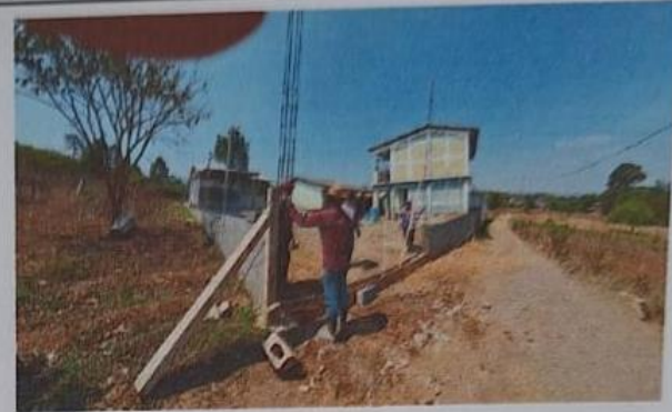
Foto 2: REPARACION DE TUBO HG Y MALLA GALBANIZADA
