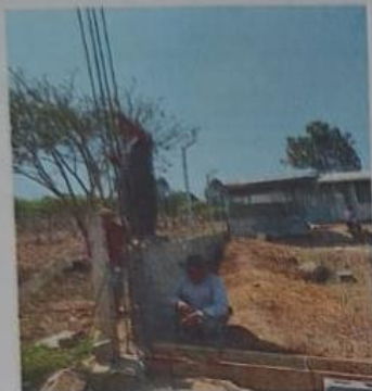
Foto 1: REPARACION DE MURO PERIMENTAL DE BLOCK CON TUBO HG Y MALLA GALBANIZADA, SOLERAS INTERMEDIAS Y COLUMNAS
