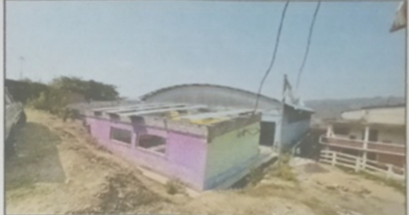
Foto 2: Módulo 1, instalación de estructura portante y lámina troquelada.
