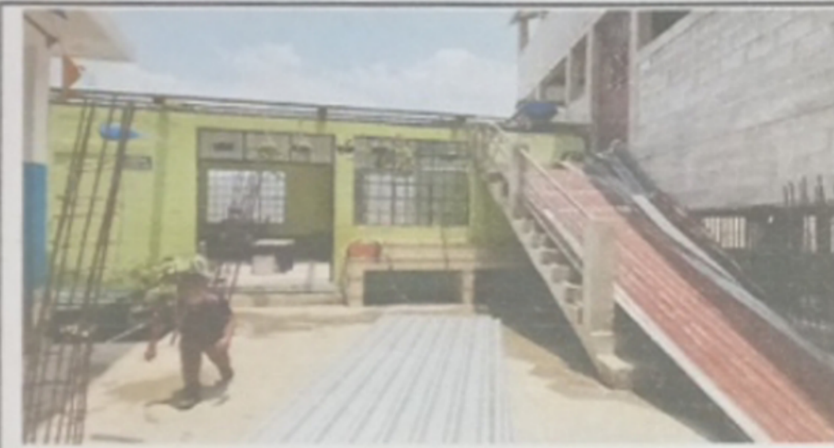
Foto 3: Módulo 2, desinstalación de lámina, capote y elementos de fijación.
