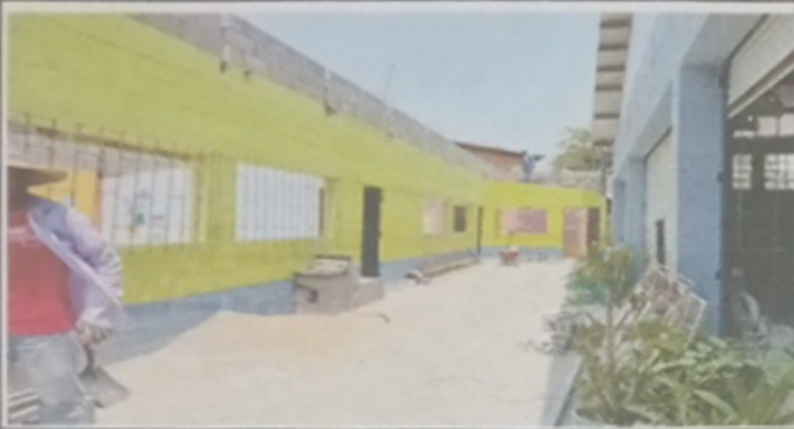
Foto 1: Módulo 1, colocación de block y desinstalación de ventanas de metal.
