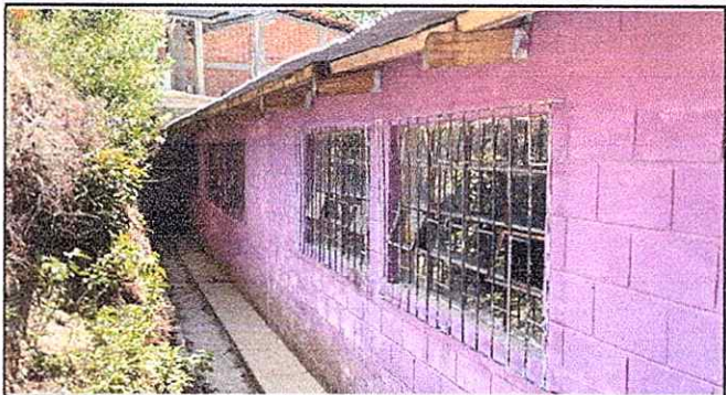
Foto 2: Sustitución de estructura de metal de ventana por PVC.
