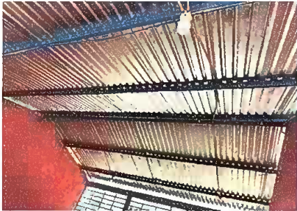
Foto 5: Módulo 3, Mantenimiento a estructura de soporte de metal.
