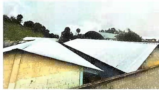
Foto 2: modulo 4,Sustitución de lámina por lámina troquelada aluzinc calibre 26.
