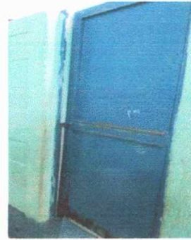
Foto 4: Módulo 2, Sustitución de puerta en servivio sanitario.
