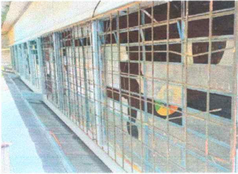
Foto 3: Modulo 3, Sustitución de vidrios.
