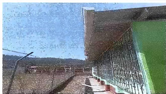
Foto 3: lado oriente la malla es deteriorada y 6 canales inservibles
