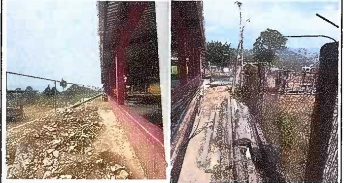
Foto 2: lado norte malla se cambio maya y se elimino poste por tubo HG
