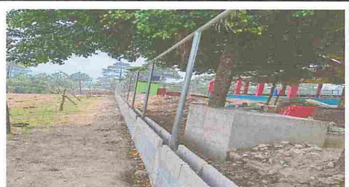
Foto 4: base para la colocación de la malla
