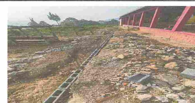
Foto 5: Cambio de la base Para la colocacion de la malla
