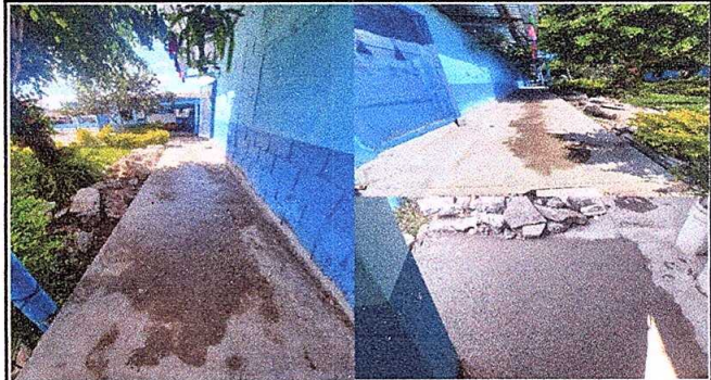
Foto 2: Módulo 1: Reparación de piso de torta de concreto
