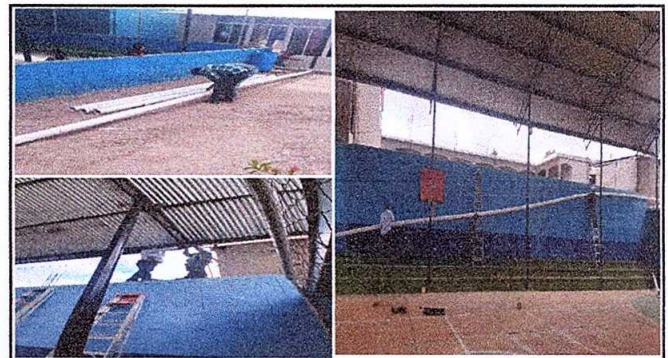
Foto 4: CANCHA DEPORTIVA: Reparación de agua pluvial, tubo PVC 3".
