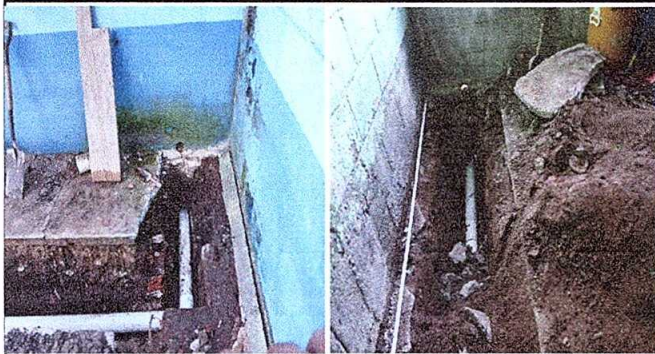
Foto1: Módulo 1: Sustitucion de tubería PVC para aguas negras línea principal.
