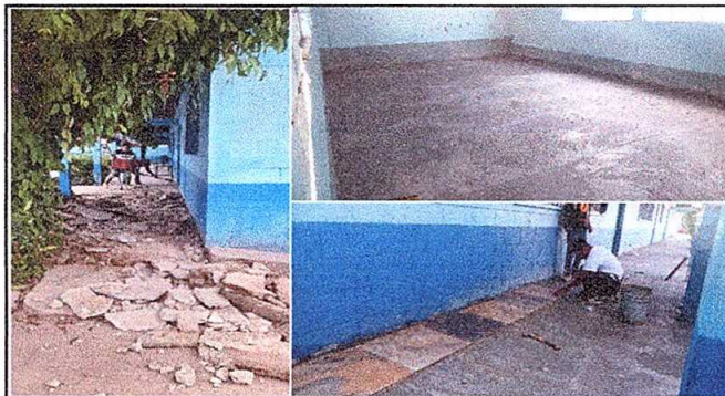
Foto 3: Módulo 2: Reparación de piso de torta de concreto por piso cerámico.
