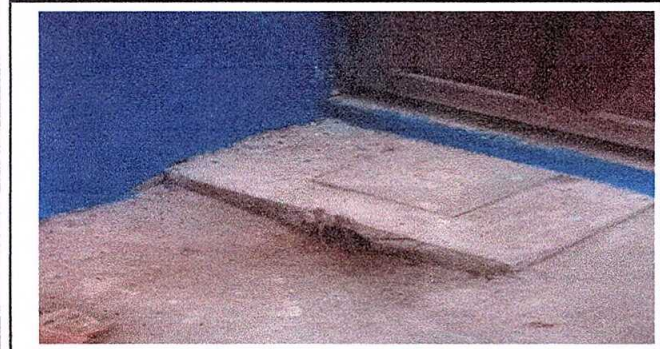
Foto 1: Módulo 1: Sustitución de tubería PVC para aguas negras línea principal.
