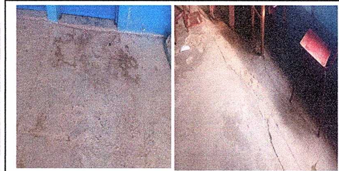
Foto 3: Módulo 2: Reparación de piso de torta de concreto por piso cerámico.
