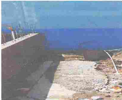
Foto 15: Sustitución de pila
