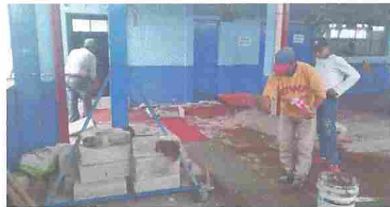
Foto 6: Sustitución de drenaje
