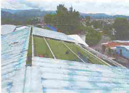
Foto 9: Reparación de techo
