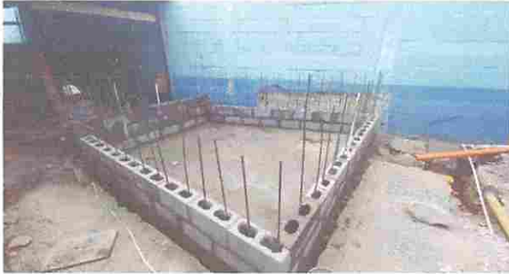
Foto 13: Sustitucion de pila
