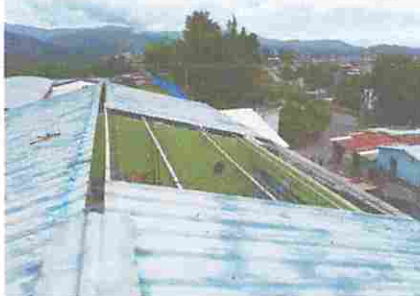
Foto 11. Reparación de canales del segundo nivel de aulas
