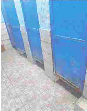
Foto 1: Sustitución de puertas
