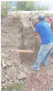
Foto 5: Sustitución de drenaje
