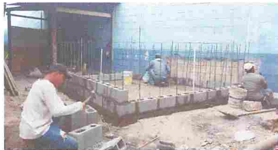
Foto 14: Sustitución de pila
