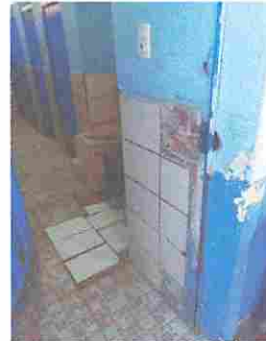
Foto 2: Sustitución de repello y pintura
