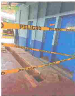
Foto 3: sustitución de drenaje
