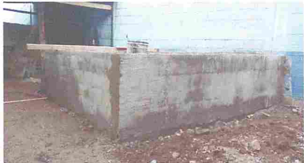
Foto 16: Sustitución de pila
