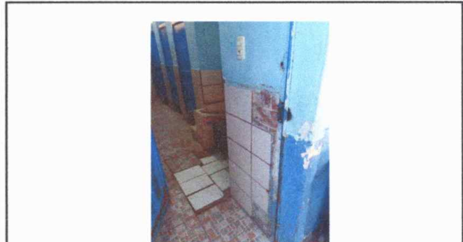
Foto 2: Sustitución de repello y pintura
