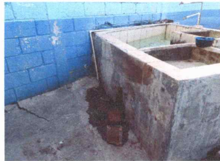
Foto 16: Sustitución de pila
