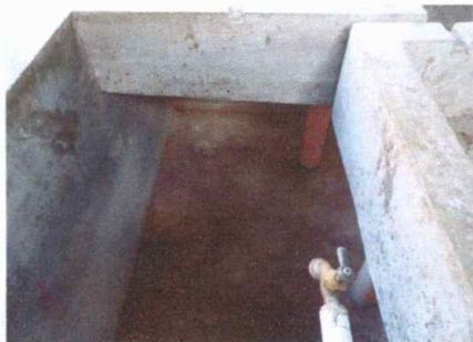
Foto 17: Sustitución de pila
