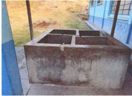
Foto 13: Sustitución de pila
