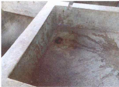
Foto 15: Sustitución de pila
