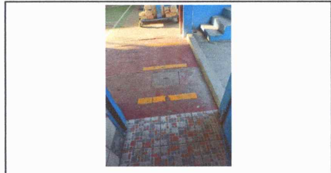
Foto 6: Sustitución de drenaje
