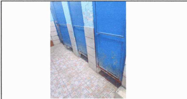
Foto 1: Sustitución de puertas
