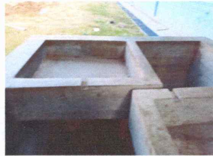
Foto 14: Sustitución de pila
