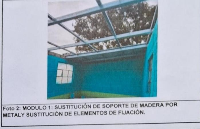
Foto 2: MODULO 1: SUSTITUCIÓN DE SOPORTE DE MADERA POR METAL Y SUSTITUCIÓN DE ELEMENTOS DE FIJACIÓN.
