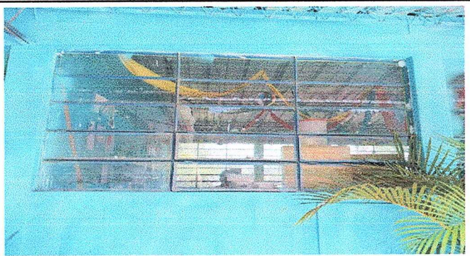
Foto 9. Modulo 5: Fabricación e instalación de balcones.
