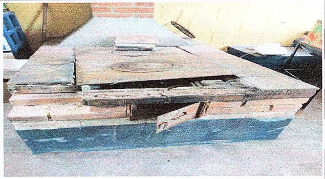
Foto 8. Modulo 4: Sustitución de plancha de metal de 3 hornillo y mantenimiento a estufa rural.
