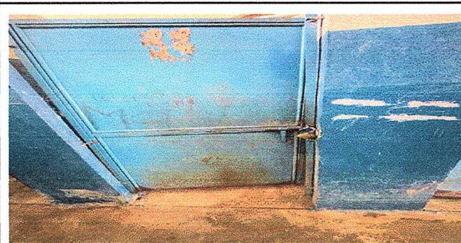
Foto 5. Modulo 2: sustitución de puertas.
