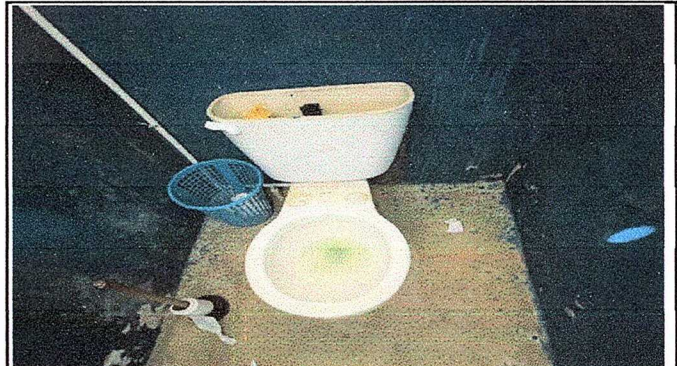
Foto 4. Modulo 2: Sustrucción de inodoros.
