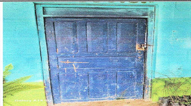
Foto 3. Modulo 1: Sustrucción de puertas.
