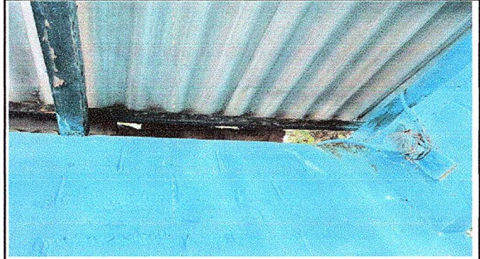
Foto 2. Modulo 1: Sustrucción de estructura de soporte de madera por metal y sustitución de elementos de fijación.
