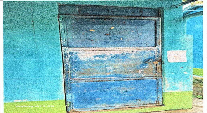
Foto 10. Modulo 5: Mantenimiento a estructura (lijado, cambio de tubo, cepillado, sujeciones, aplicación de pintura
