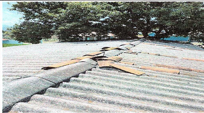
Foto 1. Modulo 1: Sustrucción de Lámina.
