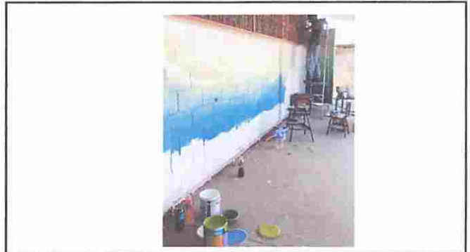
FOTO 2: PINTURA EN MUROS EXTERIORES E INTERIORES
