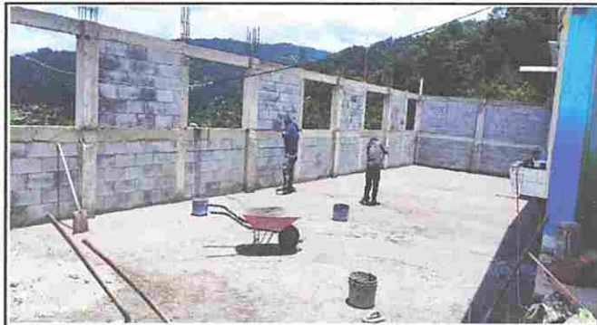
FOTO 3 PATIO: SUSTITUCIÓN DE PISO DE TORTA DE CONCRETO
