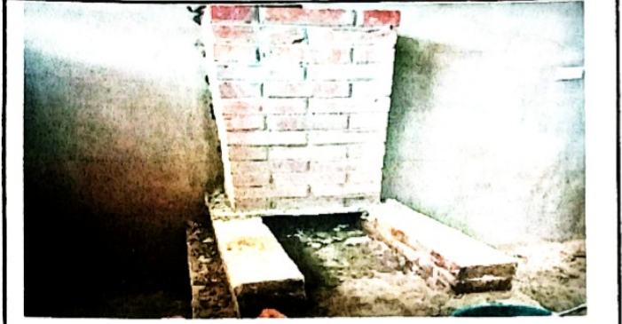
Foto 7: MODULO 2 sustitución de estufa mejorada y chimenea de ladrillo
