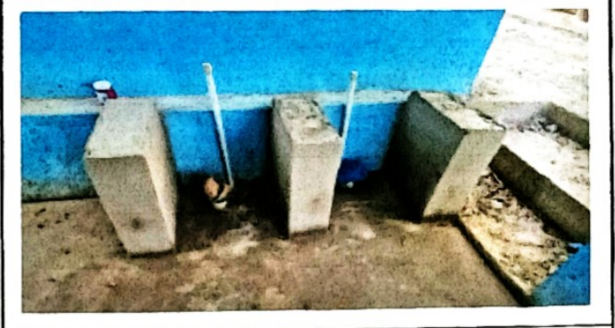
Foto 8: AREAS EXTERIORES suministro e instalación de lavamanos
