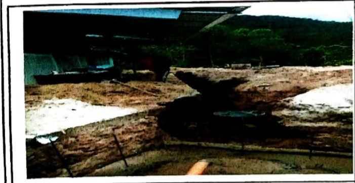
Foto 11 AREAS EXTERIORES. Suministro e Instalación de biodigestor (incluye caja de lodos)
