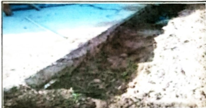
Foto 2: MODULO 2 sustitución de tubería principal de agua pluvial.
