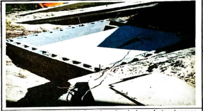
Foto 10 AREAS EXTERIORES. Suministro de caja de recolector de aguas pluviales 1mt. X 1mt.
