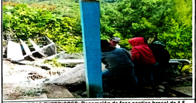
Foto 12 AREAS EXTERIORES: Reparación de fosa séptica brocal de 1.5
