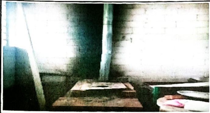
Foto 7: MODULO 2 sustitución de estufa mejorada y chimenea de ladrillo
