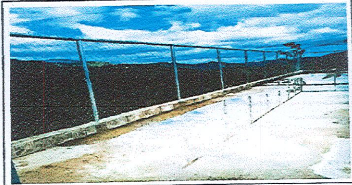
FOTO 2: MODULO 1: Reparación de muro perimetral de blok, con tubo HG y malla galvanizada, soleras intermedias y columnas.
