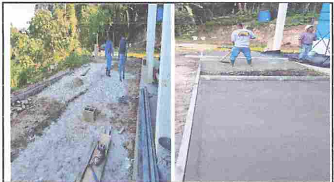
Foto 1: PATIO Se esta ejecutando el piso de torta de concreto.
