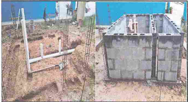
Foto 3: PATIO Construyendo la pila de concreto.
