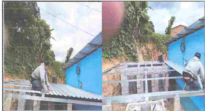
Foto 4: Colocacion del techado sobre la pila de concreto.
