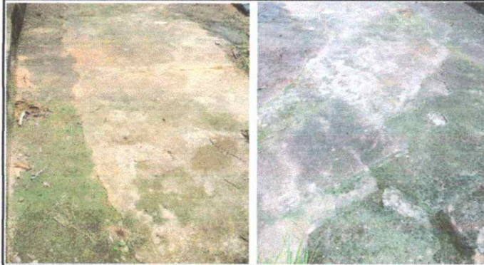
Foto1: PATIO Sustitución de piso de torta de concreto
