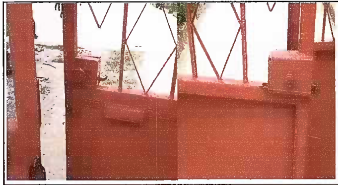
Foto 8. Módulo 2: Sustitución de Chapa.
