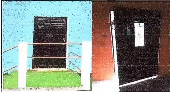
Foto 4. Módulo 1: Suministro e instalación de puerta de metal en módulo.
