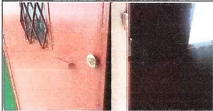
Foto 6. Módulo 1: Sustitución e instalación de chapa de puerta de metal.
