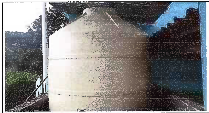
Foto 7. Módulo 1: Sustitución de depósito de agua 2500 lts.
