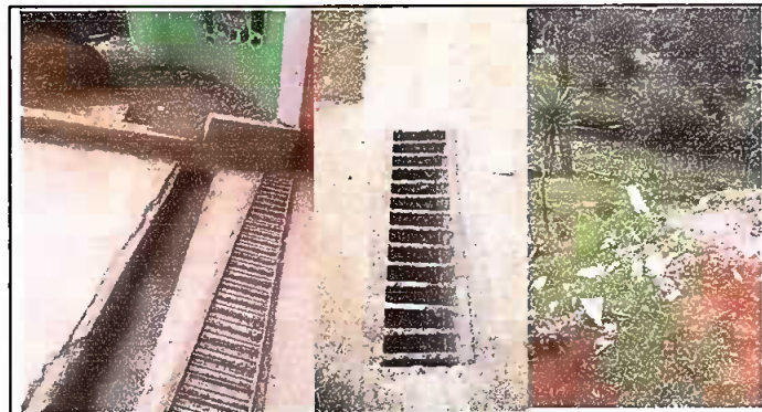
Foto 9. Módulo 2: Sustitución de Tubería PVC de línea principal de aguas pluviales.
