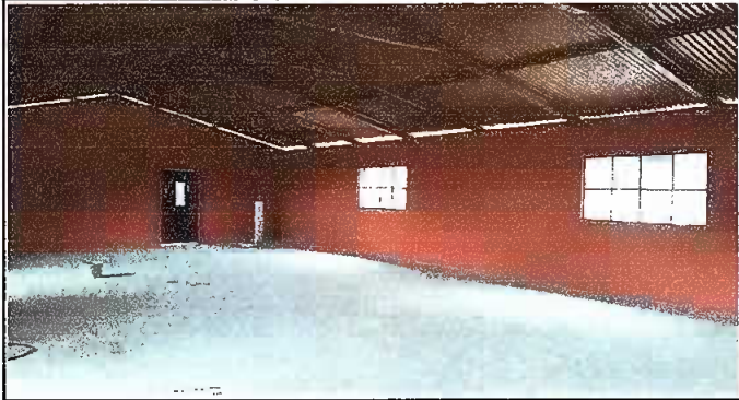
Foto 1. Módulo 1: Reparación de muro de block
