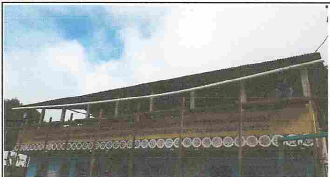
Foto 3. Módulo 1: Sustitución de bajada de Agua Pluvial.
