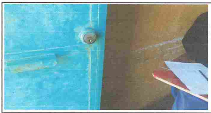
Foto 6. Módulo 1: Sustitución e instalación de chapa de puerta de metal.
