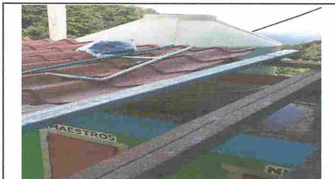
Foto 4. Módulo 1: Sustitución de depósito de agua 2500 lts.
