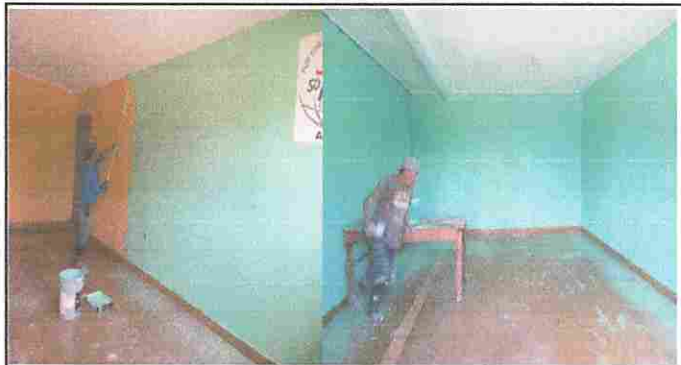
Foto 2. Módulo 3: Pintura general.
