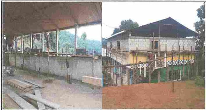
Foto 1. Módulo 1: Reparación de muro de block.
