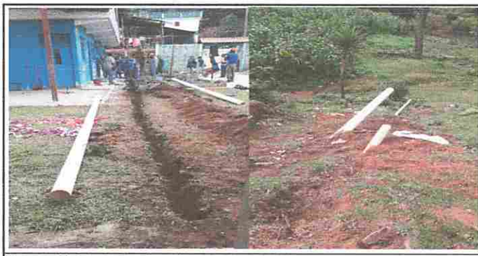
Foto 5. Módulo 2: Sustitución de Tubería PVC de línea principal de aguas pluviales.
