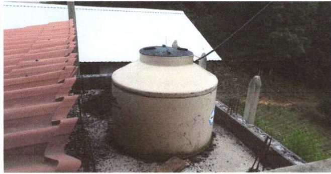
Foto 7. Módulo 1: Sustitución de depósito de agua 2500 lts
