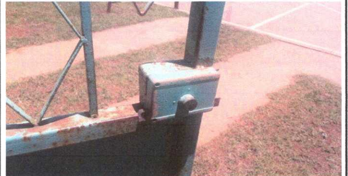
Foto 8. Módulo 2: Sustitución de Chapa
