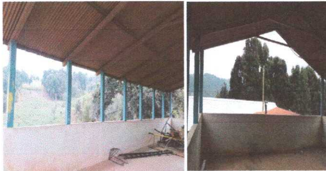
Foto 1. Módulo 1: Reparación de muro de block
