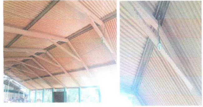
Foto 2. Módulo 1: Sustitución de Plafoneras
