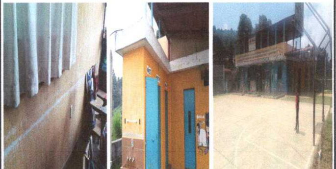
Foto 10. Módulo 3: Pintura General
