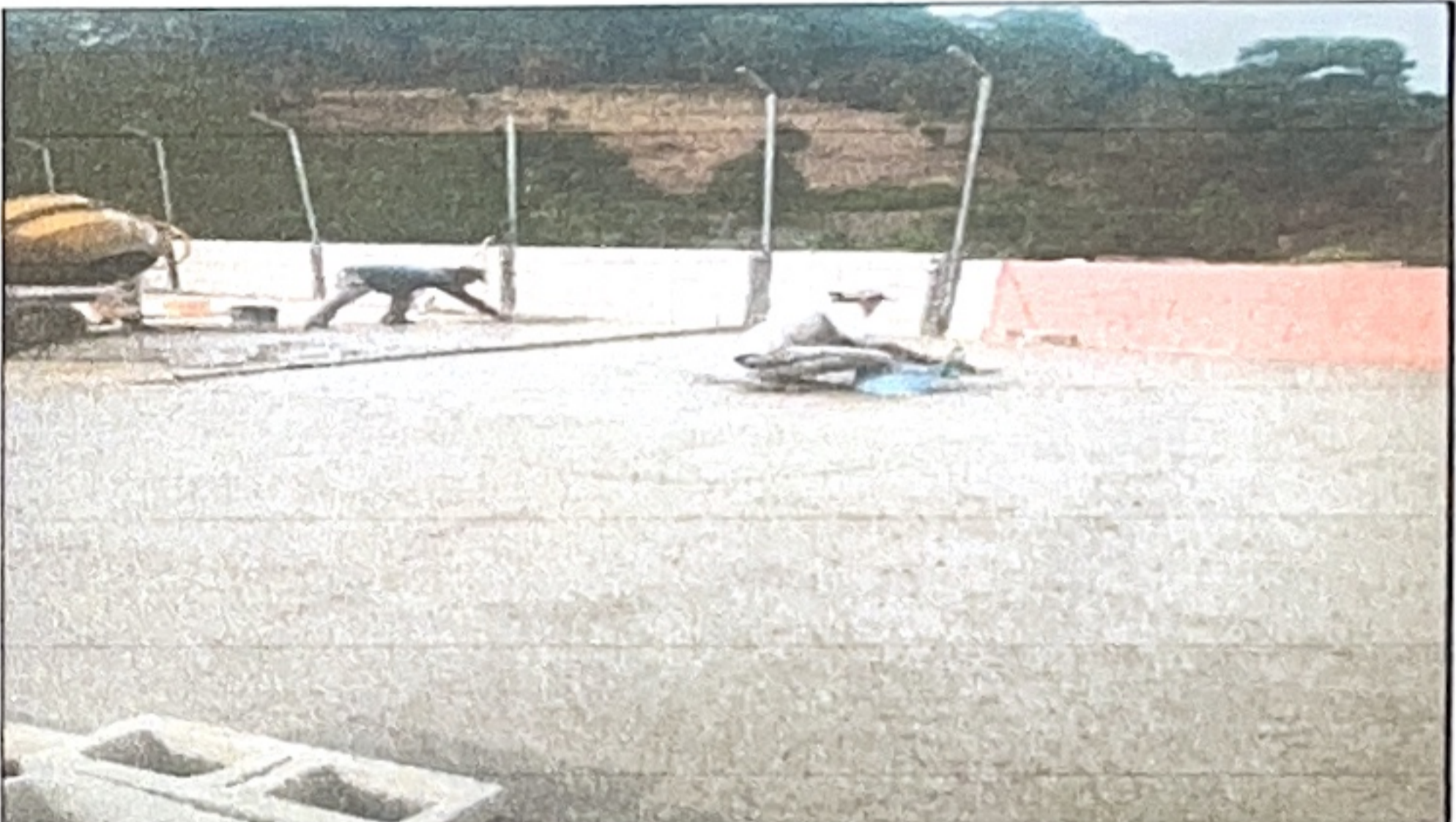
Foto 4: Modulo 2. Reparación de planchas de concreto de patio.
