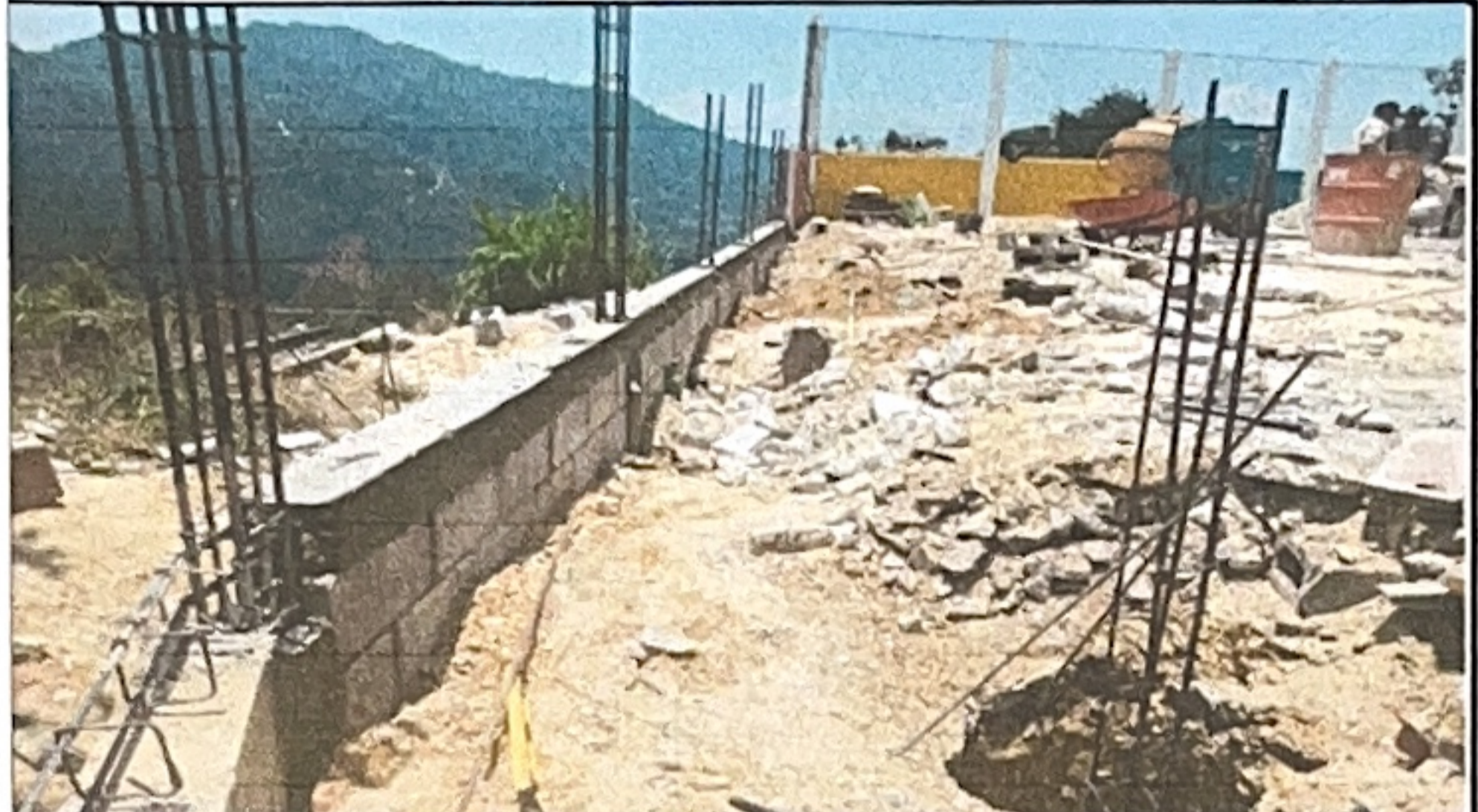
Foto 1: Modulo 1. Reparación de muro perimetral de block.
