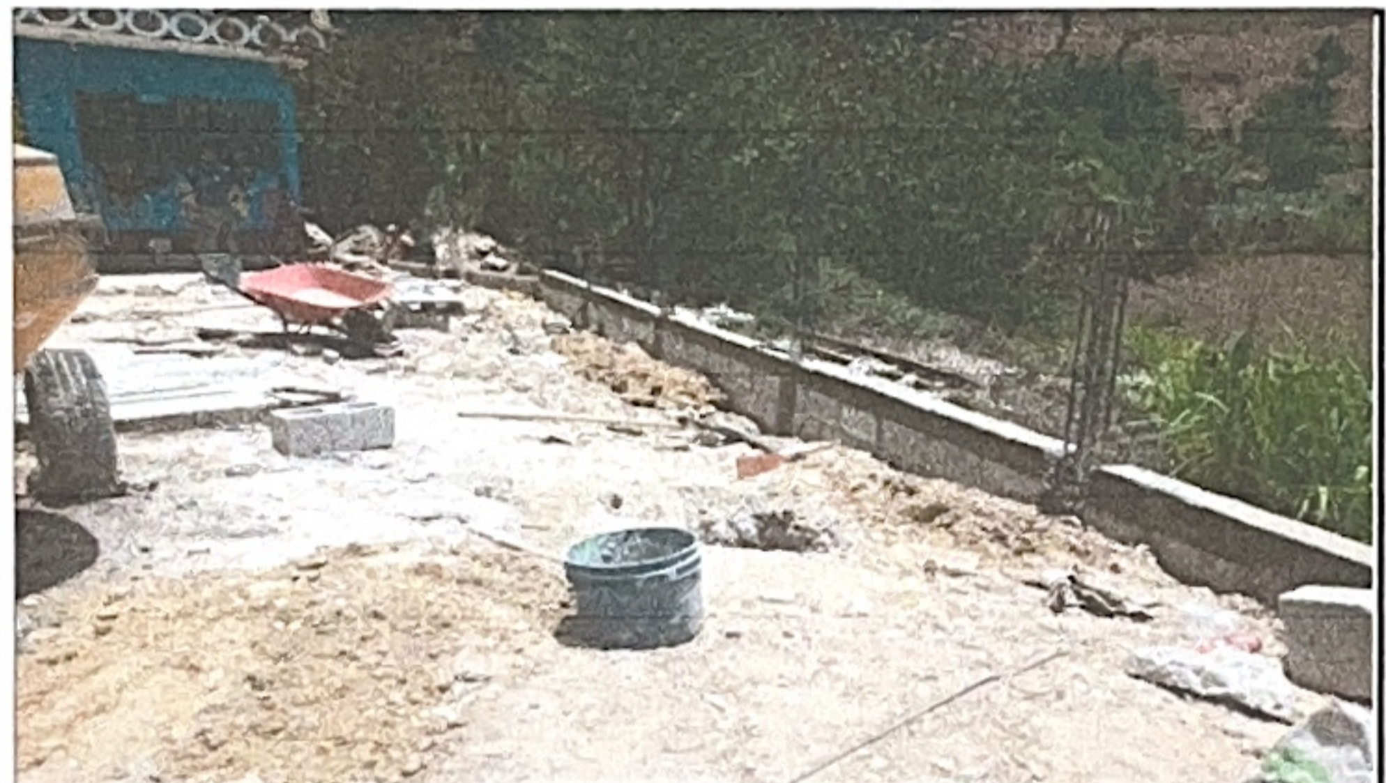
Foto 3: Modulo 2. Reparación de planchas de concreto de patio
