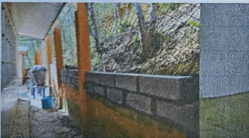
Foto 5: reparación de muro perimetral
