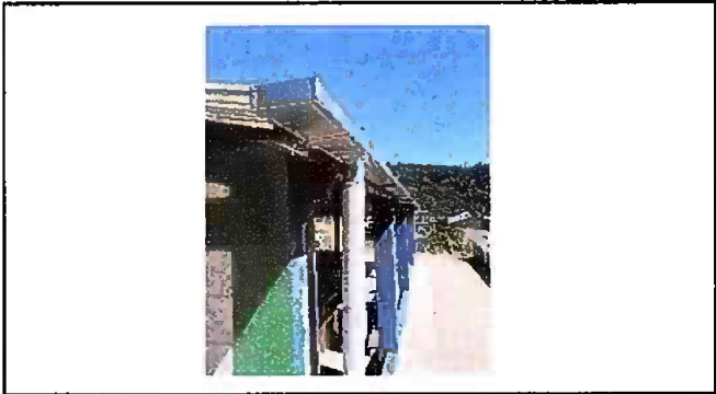
Foto 14: Modulo 2: Sustitución de canal de metal
