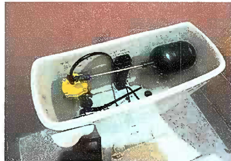
Foto 12: Modulo 1: Sustitución de accesorios inodoro (contra llave, tubo de abasto y tanque)
