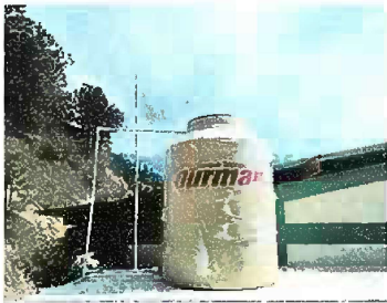
Foto 11: Modulo 1: Sustitución de depósito de agua 1100 lt
