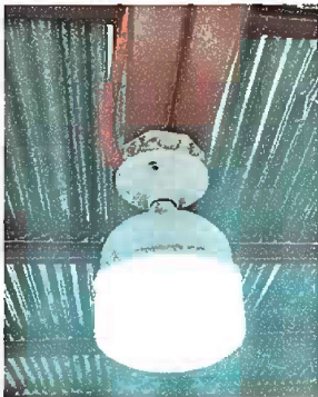
Foto 9: Modulo 1: Sustitución de focos ahorradores
