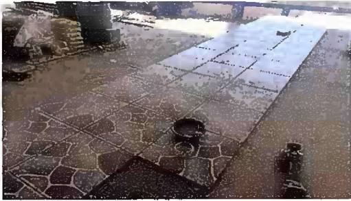
Foto 13: Modulo 2: Sustitución de piso cerámico
