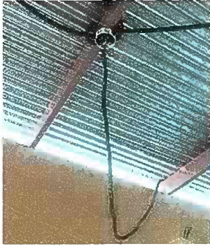
Foto 7: Modulo 1: Reparación de cableado electrico
