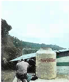
Foto 11: Modulo 1: Sustitución de depósito de agua 1100 lt
