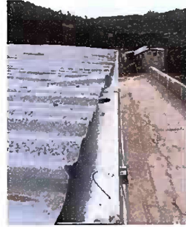
Foto 14: Modulo 2: Sustitución de canal de metal
