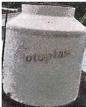
Foto 11: Modulo 1: Sustitución de depósito de agua 1100 lt
