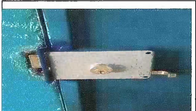
Módulo 3: Sustitución de chapa
