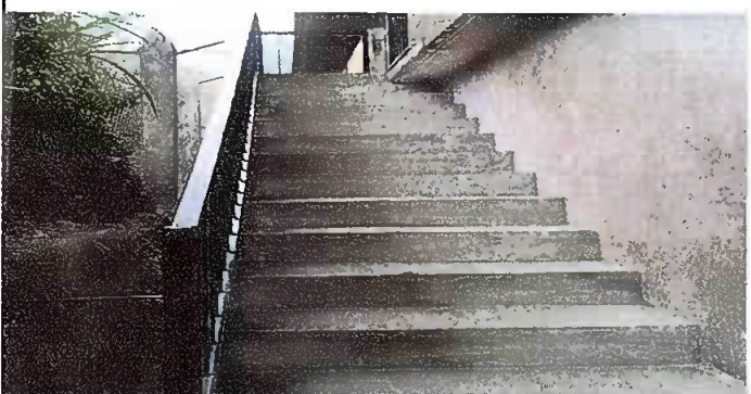
Módulo 1: Sustitución de gradas de concreto
