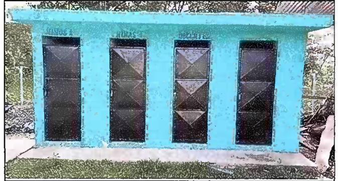
Mantenimiento a estructura (lijado,cambio de tubo, cepilado,sujecion,aplicación de pintura) a puertas servicios sanitarios
