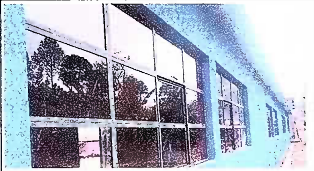
Foto 3: Sustitución de estructura de metal de ventana
