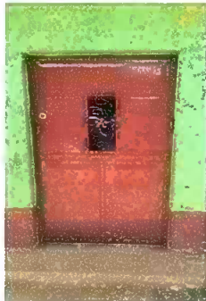
Foto 3: Módulo 2, Sustitución de puerta de madera por metal.
