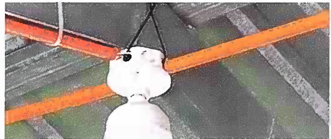
Foto 6: Módulo 1. Sustrucción de plafoneras
