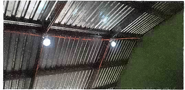
Foto 2: Módulo 1, sustitución de ducto eléctrico + accesorios.
