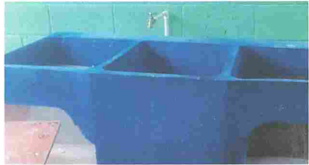
Foto 4: Módulo 2. Colocación de pila nueva; de concreto.
