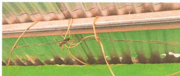
Foto 2: Módulo 1, Sustitución de ducto eléctrico + accesorios
