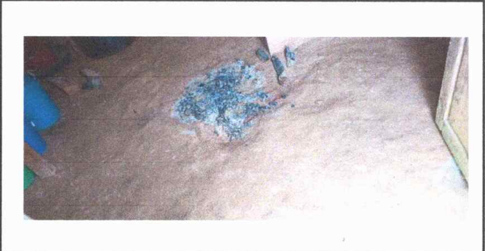
Foto 5: Módulo 2, Sustitución de piso de torta de concreto
