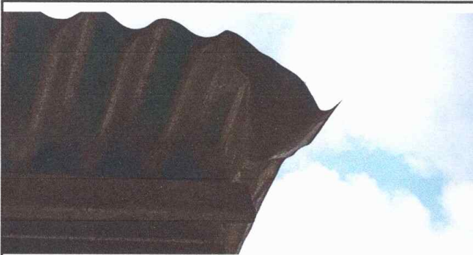
Foto 3: Módulo 1, Sustitución de Lámina
