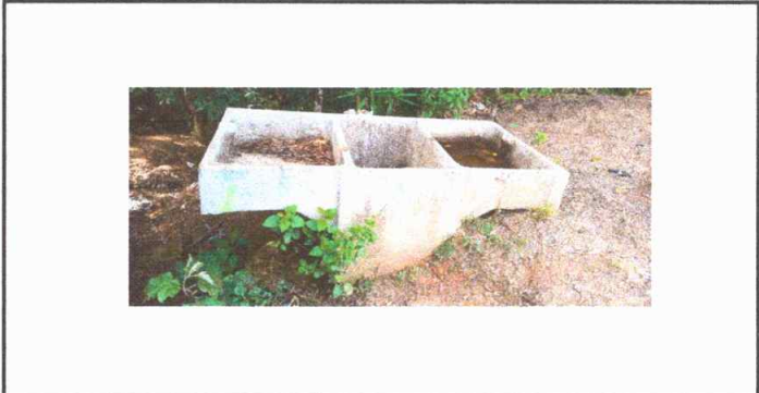
Foto 6: Módulo 2, Sustitución de pila de cemento de dos lavadero
