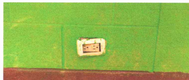
Foto 4: Módulo 1, Sustitución de tomacorriente doble
