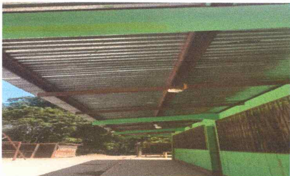
Foto 1: Módulo 1, Sustitución de estructura de soporte de metal
