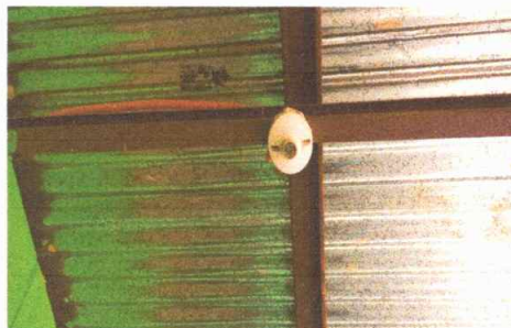
Foto 6: Módulo 1, Sustitución de plafoneras
