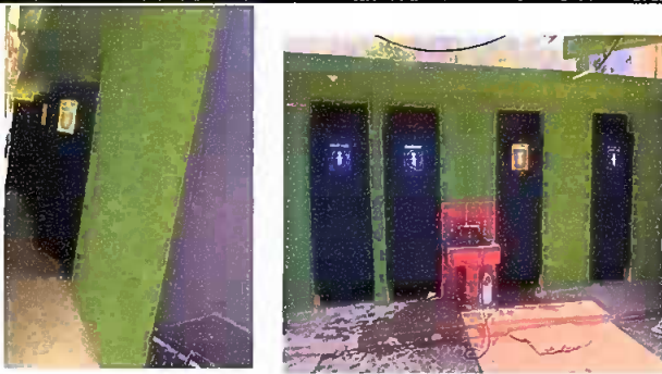
Foto 3: sustitución de pintura de puertas metálicas de los baños
