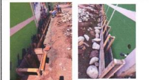
Foto 2: sustitución de parrilla metálica de la cuneta del ingreso principal del centro educativo y la reparación de la cuneta de concreto.
