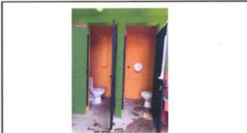
Foto 4: sustitución de los inodoros y pintado en la paredes de los baños
