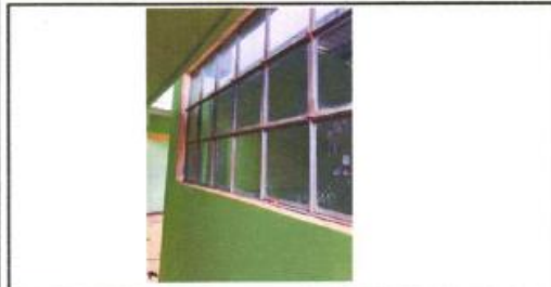
Foto 5: sustitución de vidrios
