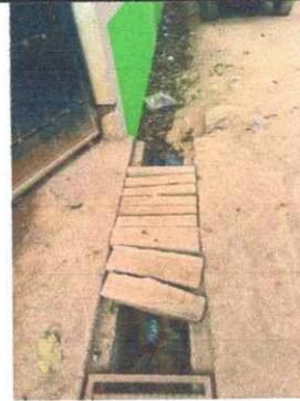
Foto 2: sustitución de parrilla metálica de la cuneta del ingreso principal del centro educativo y la reparación de la cuneta de concreto.
