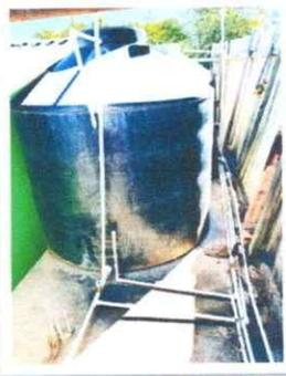
Foto1: Situación de un tinaco + sustitución de la tubería de la línea principal de agua potable de servicios sanitarios
