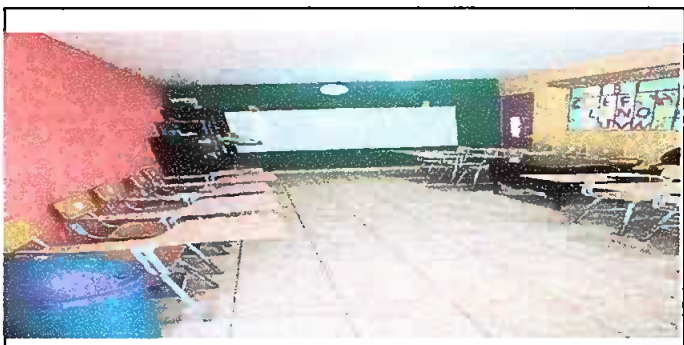
Foto 5: pintura en muros exteriores e interiores
