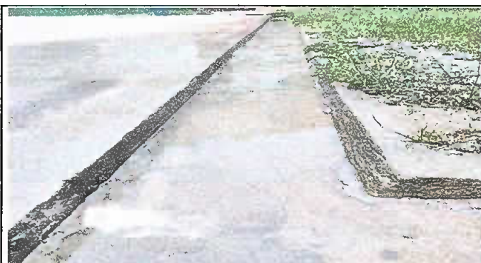
Foto 10: Reparación de cunetas de concreto
