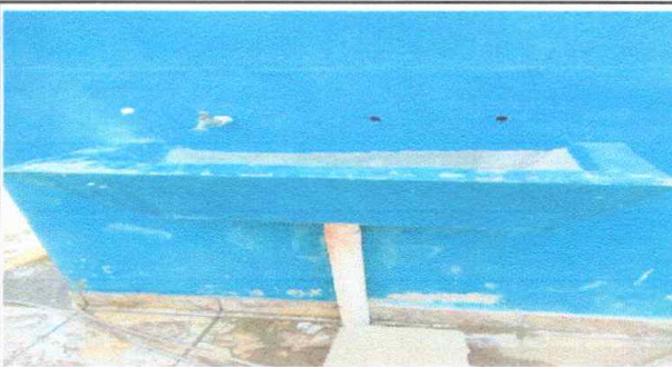
Foto 12: Sustitución de lavamanos
