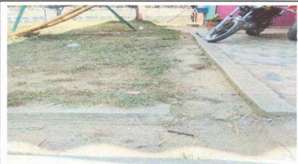
Foto 10: Reparación de cunetas de concreto
