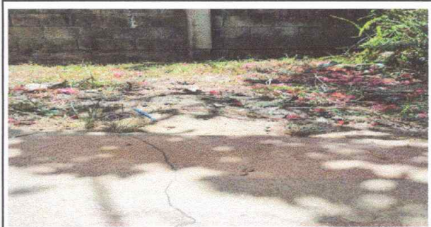
Foto 14: Sustrucción de tubería PVC línea principal aguas negras
