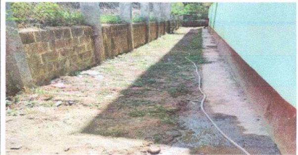
Foto 8: Reparación de torta de concreto
