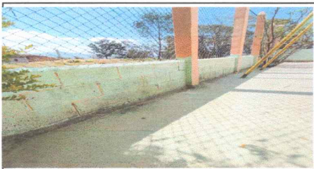
Foto 5: pintura en muros exteriores e interiores
