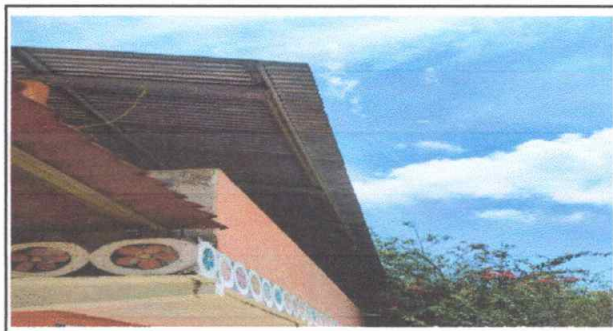
Foto 6: Sustitución de canal PVC
