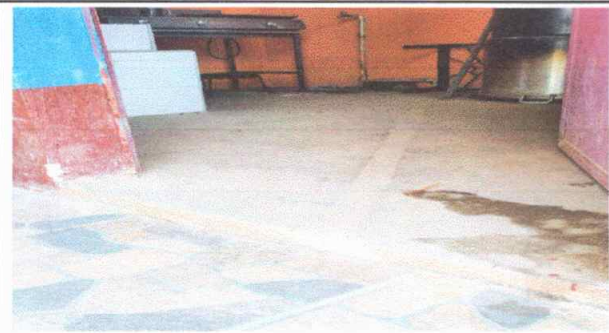
Foto 9: Reparación de piso cerámico
