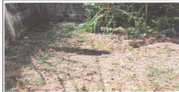
Foto 15: Reparación de fosa séptica
