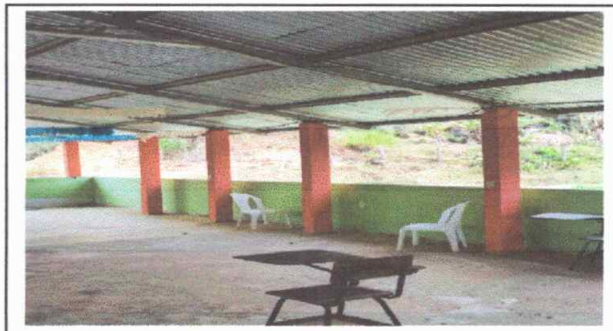
Foto 4: Reparación de muro perimetral salon de block
