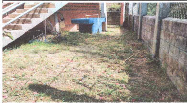
Foto 13: Sustrucción de pila de cemento 2 lavaderos
