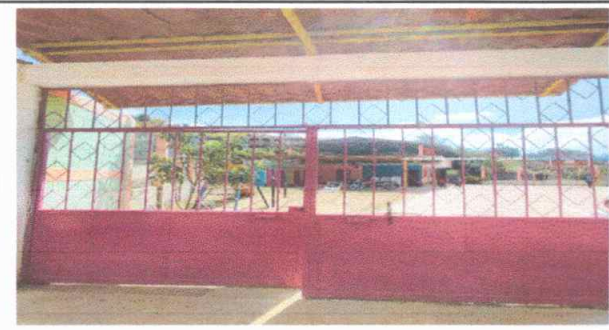
Foto 11: Mantenimiento en porton de metal
