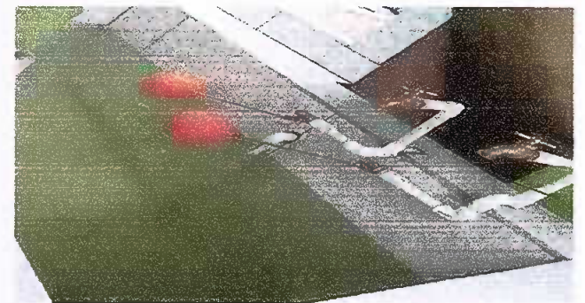
Foto 10: MODULO 3. Sustitución de tubería línea principal
