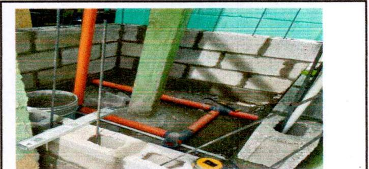
Foto 12: Sustitución de pila de cemento de dos lavadero por una formal. Aplicación de azulejo en pila de concreto
