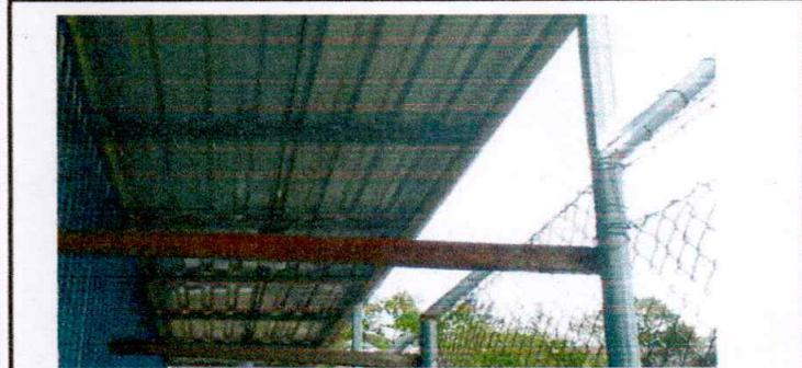
Foto 9: MODULO 2. Sustitución de estructura de soporte de madera, por metal. Sustitución de lámina, por lámina troquelada aluzinc calibre 26.
