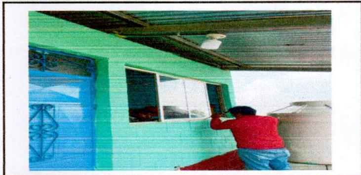
Foto7: MODULO 2 Sustitución de ventanas de aluminio por ventanas PVC, sustitución de lamparas a tipo LED y sustitución de tomacorrientes dobles
