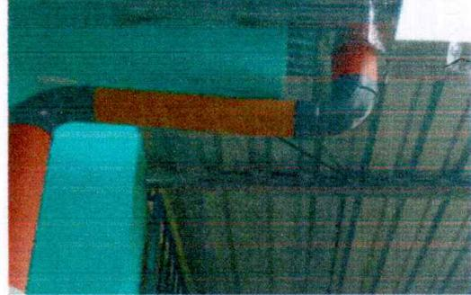
Foto 4: MODULO 1 Sustitución de canal de pvc por metal, sustitución de bajada de agua pluvial de PVC
